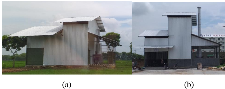
Gambar 1. Prasarana Bangunan Vertical Dryer (a) Bangunan Vertical Dryer Kapasitas 6 ton; (b) Bangunan Vertical Dryer Kapasitas 10 Ton
